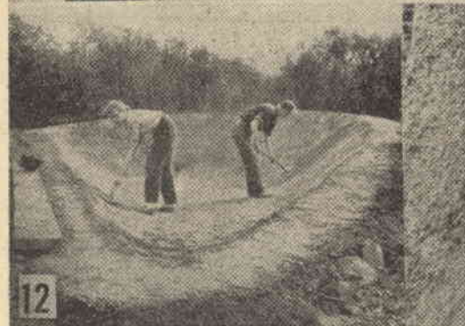
9 - L'uomo nella vasca ha il lavoro più duro: rastrellare il cemento ad uno spessore uniforme. Lo sgabello
